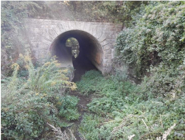
Obrázek 5 Propustek v železničním náspu v profilu PF_45_M, ř. km 6,597
