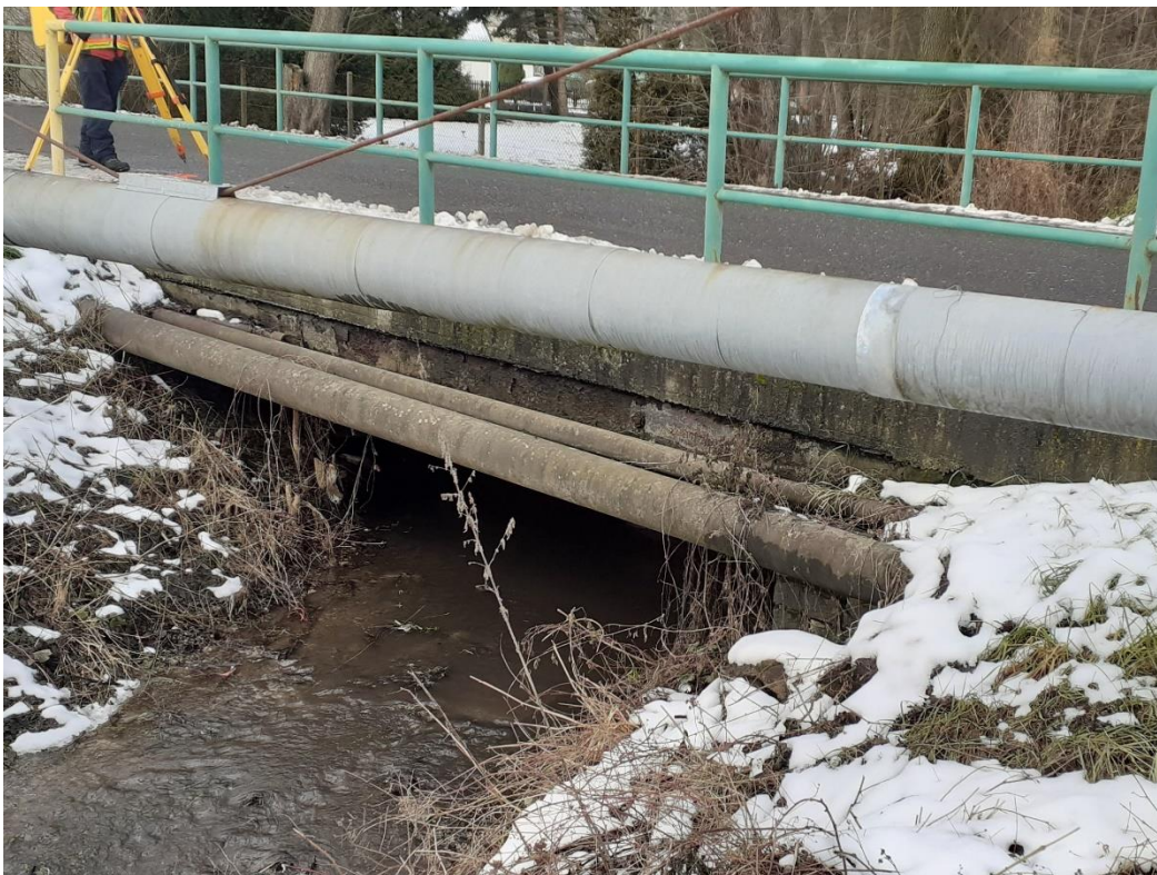
Obrázek 8 Most PF_126_M (ř. km 13,949) ve Snědovicích
