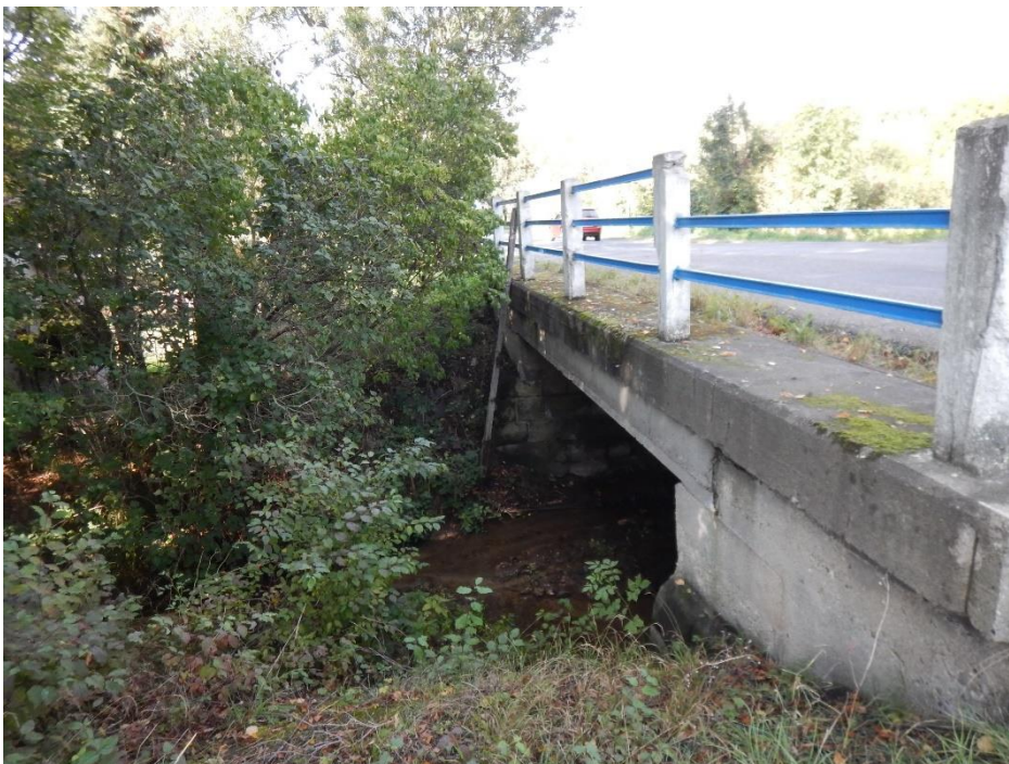
Obrázek 4 Most PF_40_M (ř. km 6,223)
